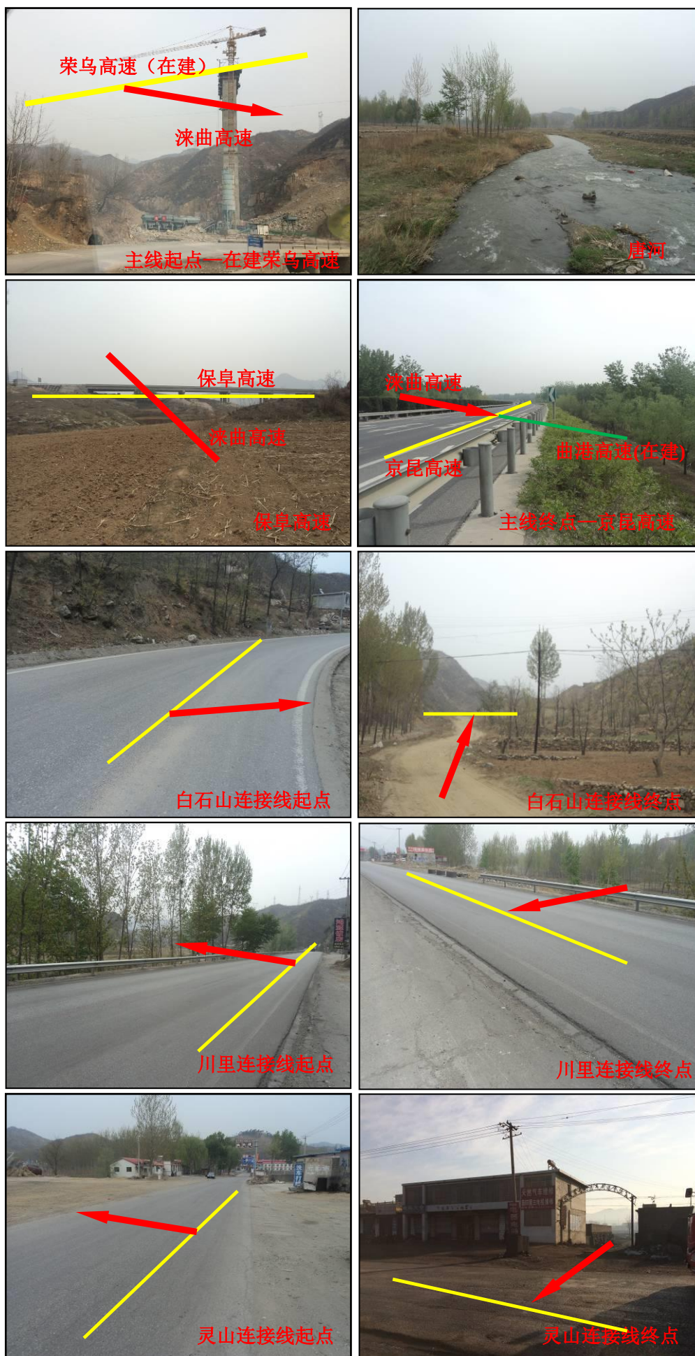
图 3.1-1 沿线现场基本情况图
