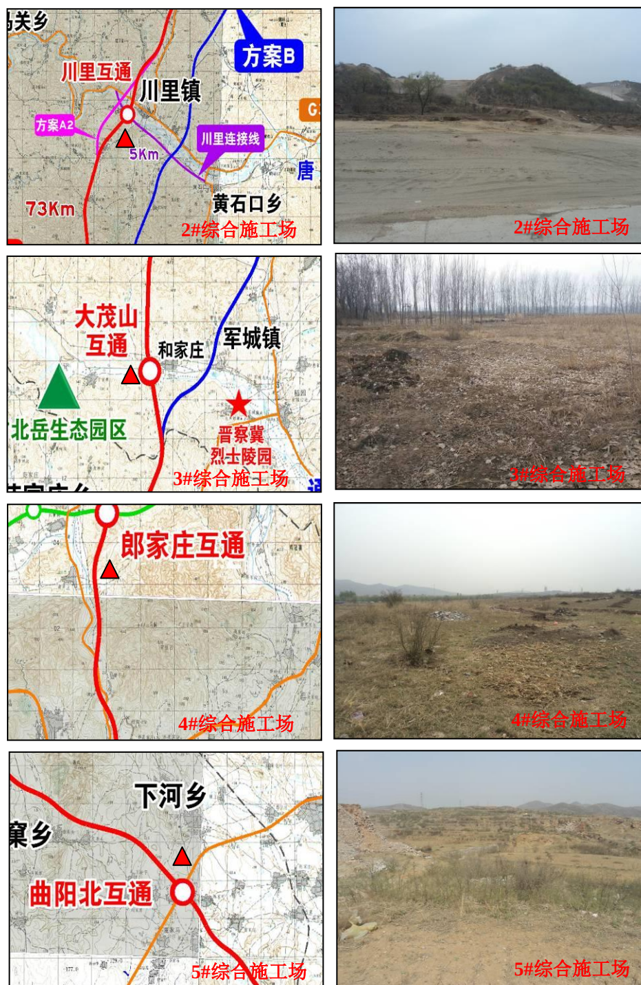
图 2.4-13 综合施工场现场情况图
