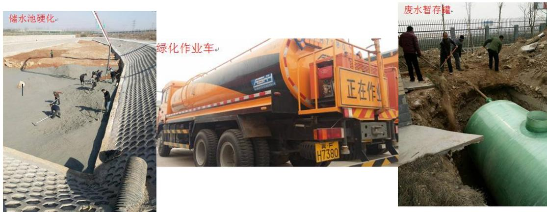
图 8.3-2 废水储存及运输设施图
