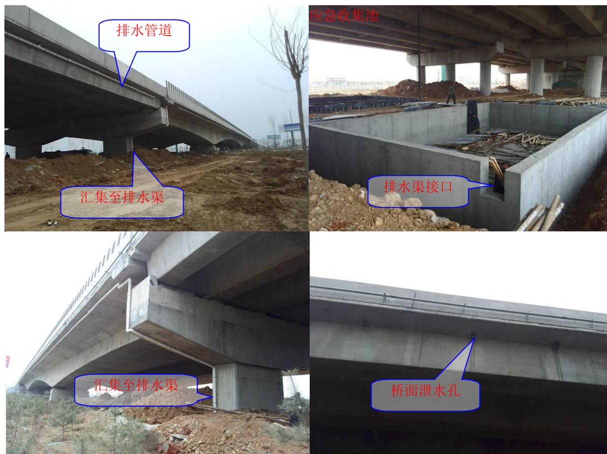
图 8.1-1 南水北调大桥雨水收集系统及防渗事故池
