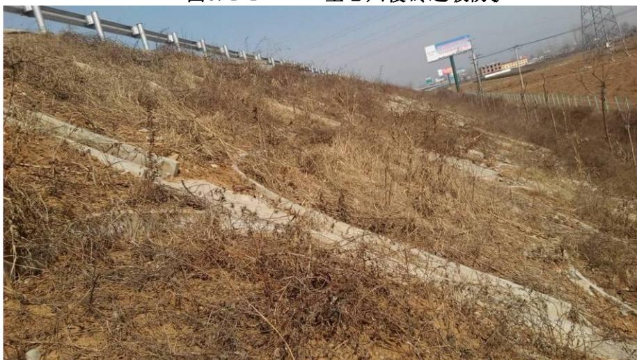
图5.4-2 拱形骨架植草边坡防护
