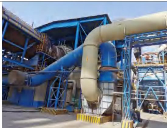
窑头废气处置装置
