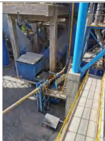
固态/半固态危废输送管道及检修口
